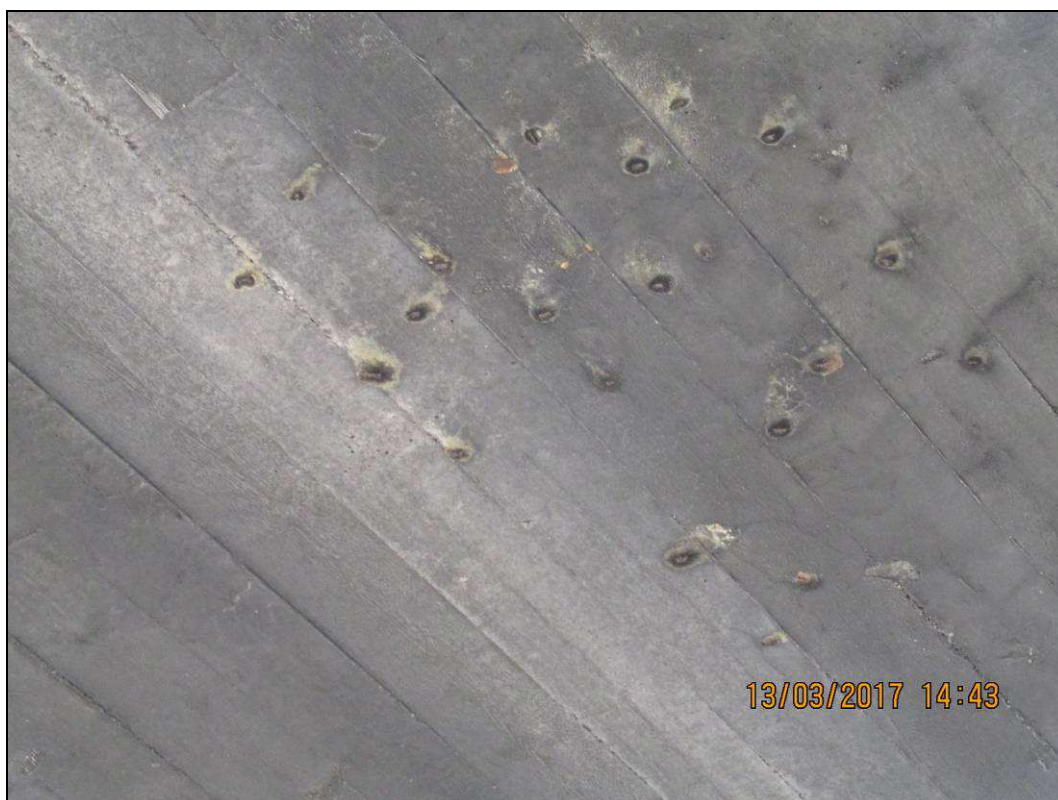
Obr. č. 6 - detail na spodní líc nosné konstrukce - v místech opadů betonu obnažena konstrukční výztuž
